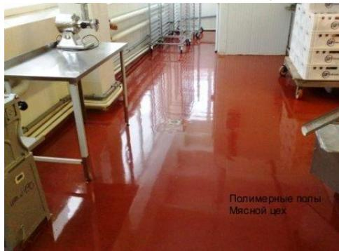
Тонкослойные полимерные покрытия используются для предотвращения пыления и защиты бетонных и цементно-полимерных полов от воздействия агрессивных сред, а так же придания полу декоративности.
