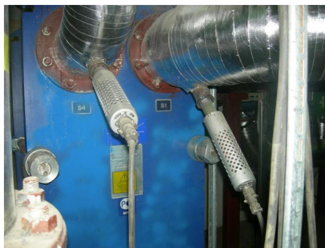
Излучатель ультразвука на пластинчатом теплообменнике. Ультразвук подаётся в воду.
