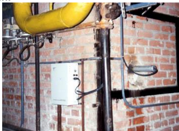
Излучатели ультразвука, приваренные к подогревателю ГВС и к коллектору парового котла. Слева от излучателя ультразвуковой генератор
