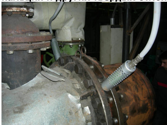
Излучатели ультразвука, приваренные к подогревателю ГВС и к коллектору парового котла. Слева от излучателя ультразвуковой генератор
